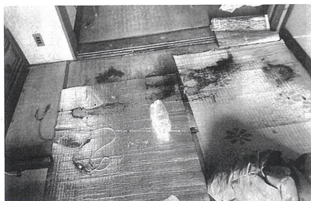
最期に倒れた入居者の痕跡が残る現場
