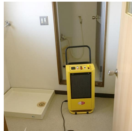
オゾン発生装置による 脱臭作業
