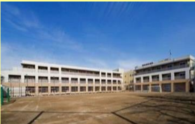
学校を改修して整備した事例
