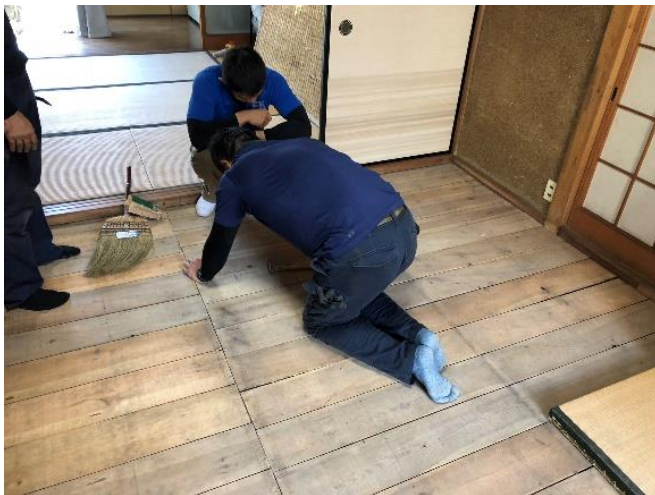
床板を剥がし進入路を確保
