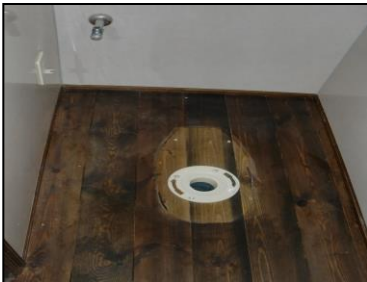
床面を洗浄し、CFを剥がす
