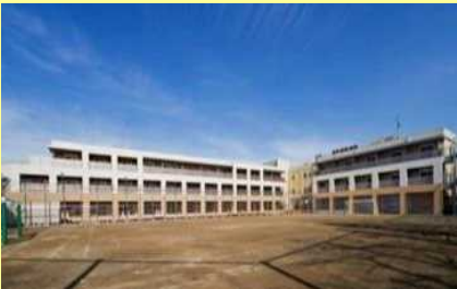
学校を改修して整備した事例
